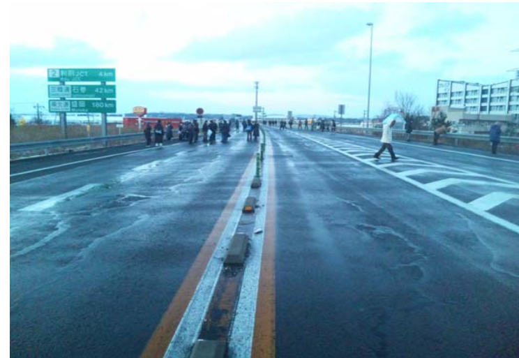
避難状況(仙台港北IC付近)
